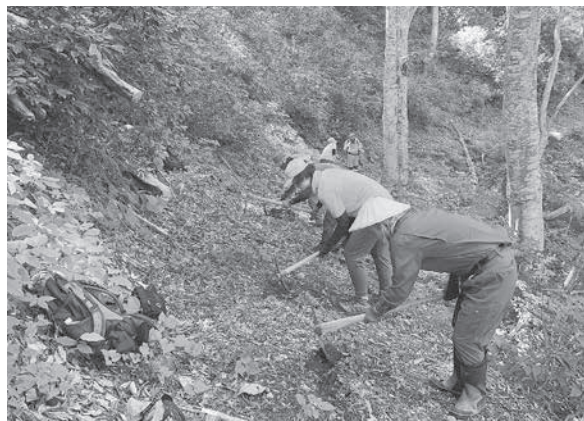
↑手作業で道を整備
