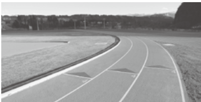
↑ 完成した中津川運動公園。写真は400mトラック3レーン
