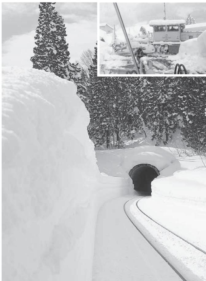
↑除雪後の雪壁ができた飯山線の線路。専用の除雪車で除雪します。
