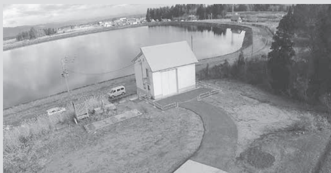
源内山ダムのほりに建設され、発電に使った水は全量ダムへ戻されます。
