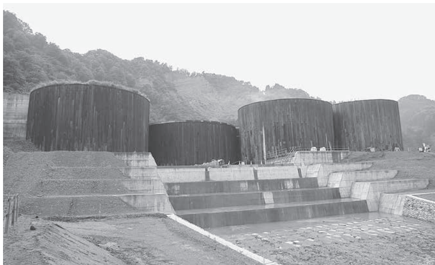
最先端の技術で建造されたセル式の砂防ダム
