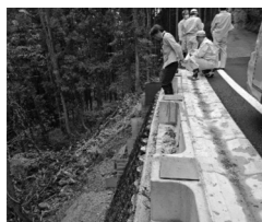
①新改第3号側溝改良工事(大割野)
