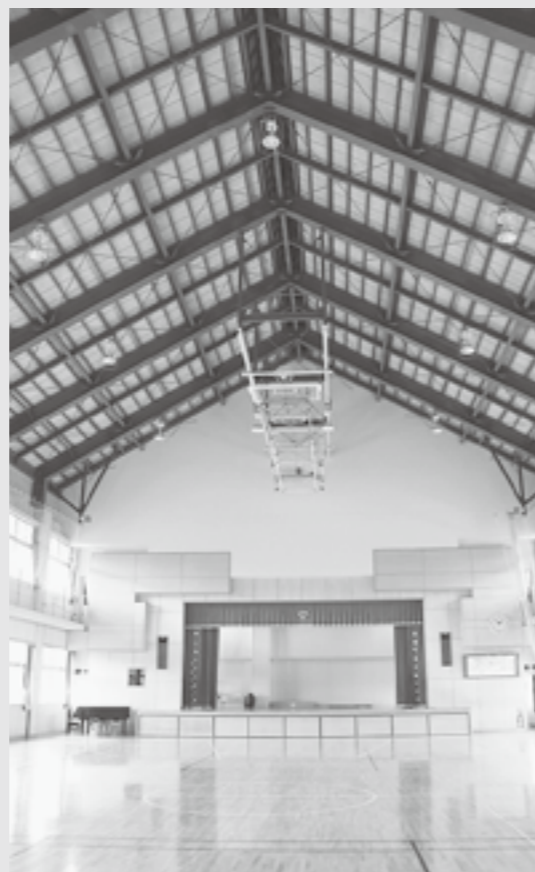
防音材を取りはずした上郷小の体育館
