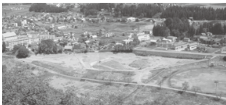
着工を待つ中津川総合グラウンド（沖の原より）
