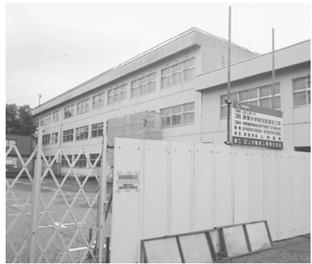
耐震工事の早期完成を（写真は津南小）
