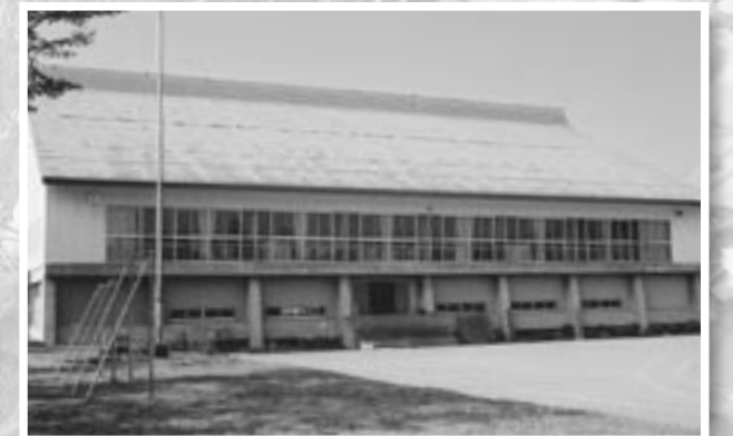
アスベスト除去(津南中体育館)
